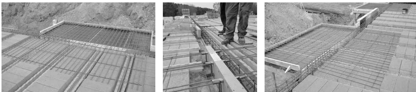
Rys. 8.8 Strefa obniżona pustaków betonowych
