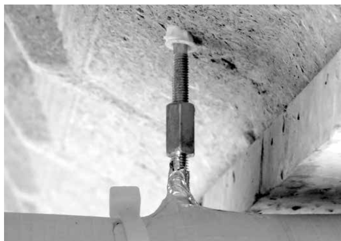
Rys. 12.9 Mocowanie do żebra nośnego stropu kanałów wentylacyjnych
