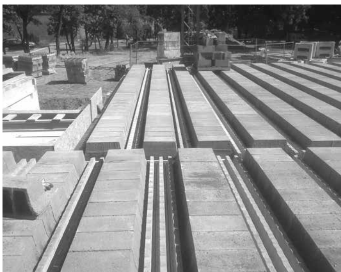
Rys. 2.8 Pustak RP20
