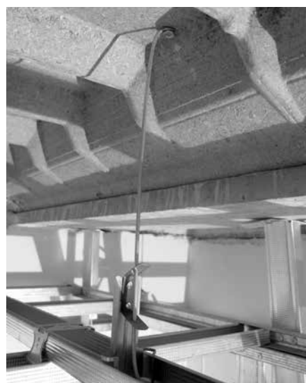
Rys. 12.10 Montaż z użyciem zawieszki drutowej montowanej bezpośrednio do płyty nadbetonu
