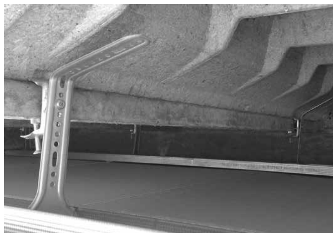
Rys. 12.8 Połączenie zawiesia z zawieszką noniuszową
