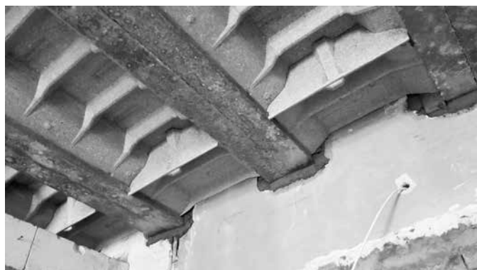
Rys. 6.5 Wypełnienie stropu żelbetem przy niestandardowym rozstawie belek RS
