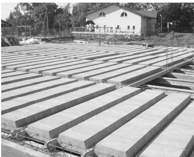
Rys. 2.10 Pustak RP25
