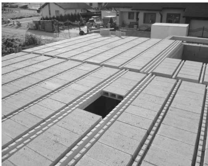
Rys. 2.11 Montaż systemu RECTOBETON
