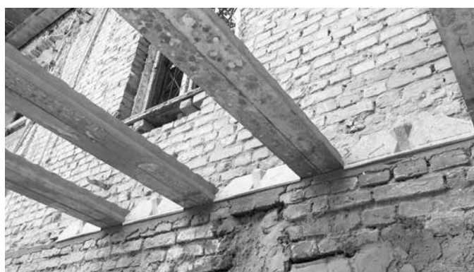
Rys. 6.6 Wypełnienie stropu dociętym pustakiem betonowym przy niestandardowym rozstawie belek RS
